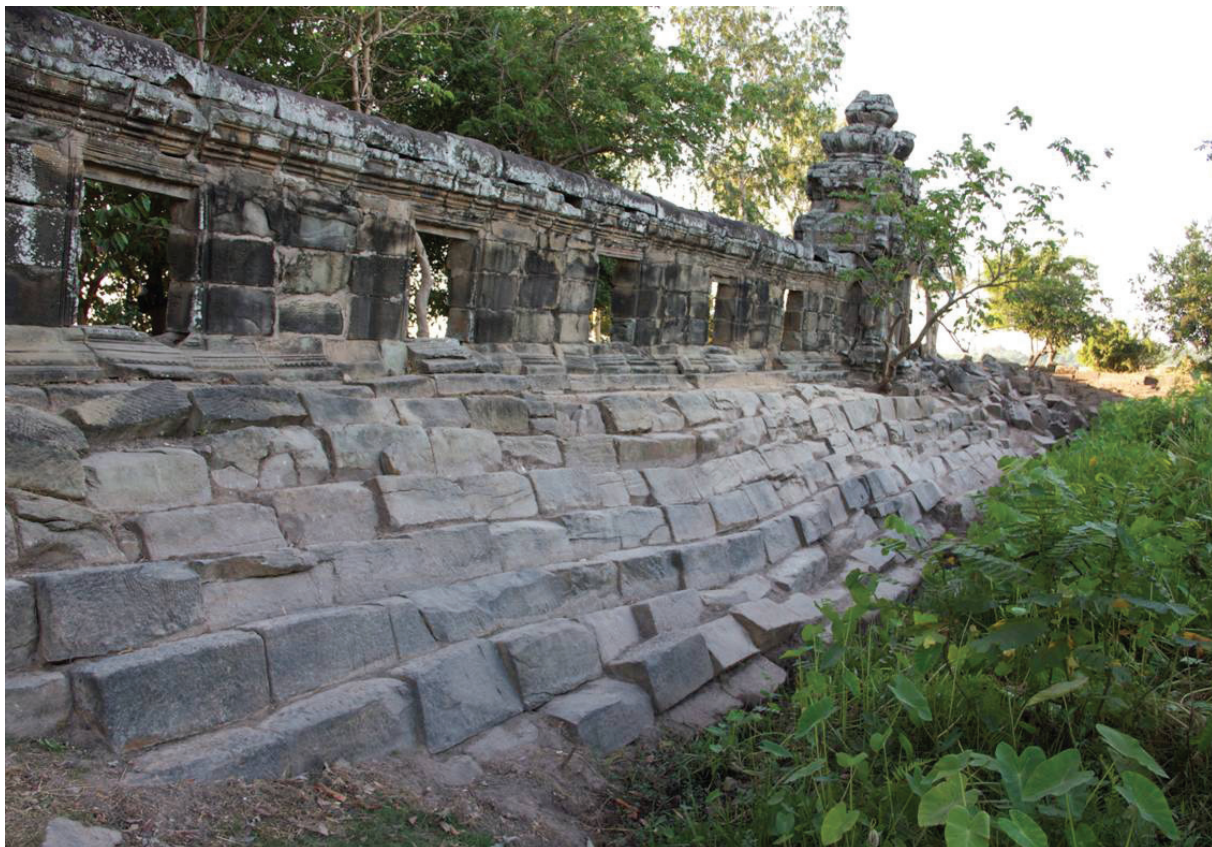
Mébon occidental : façade orientale avant dépose préventive (cliché Pascal Royère, 2013)
