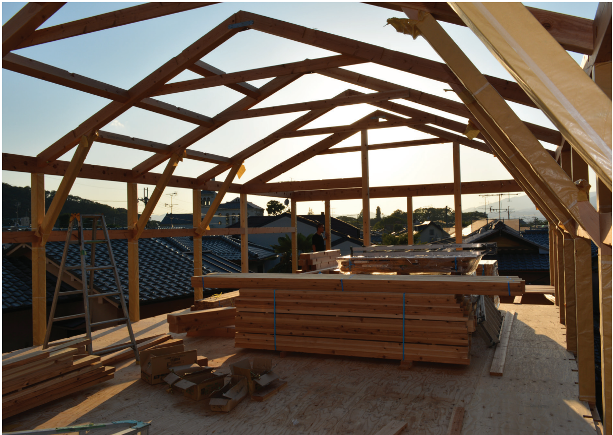
Vue dégagée sur le paysage urbain et les montagnes de l'ouest de Kyôto depuis le 2e étage du nouveau Centre EFEO de Kyôto. La structure et la charpente en bois du bâtiment ont été montées sur place en deux jours à partir de pièce de bois (poteaux et poutres) prédécoupées (cliché Benoît Jacquet, 20 septembre 2013)
