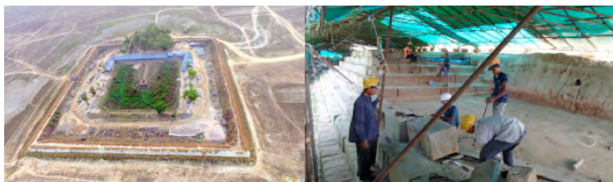
Images du chantier de restauration du Mébon occidental (Cambodge).
