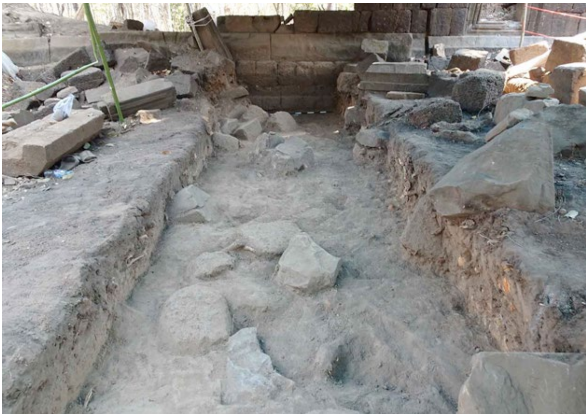
Prasat Khna ; sondage 1000, effondrement du bâtiment pérenne du Yaśodharāśrama vu de l'ouest (Cliché Yaśodharāśrama).
