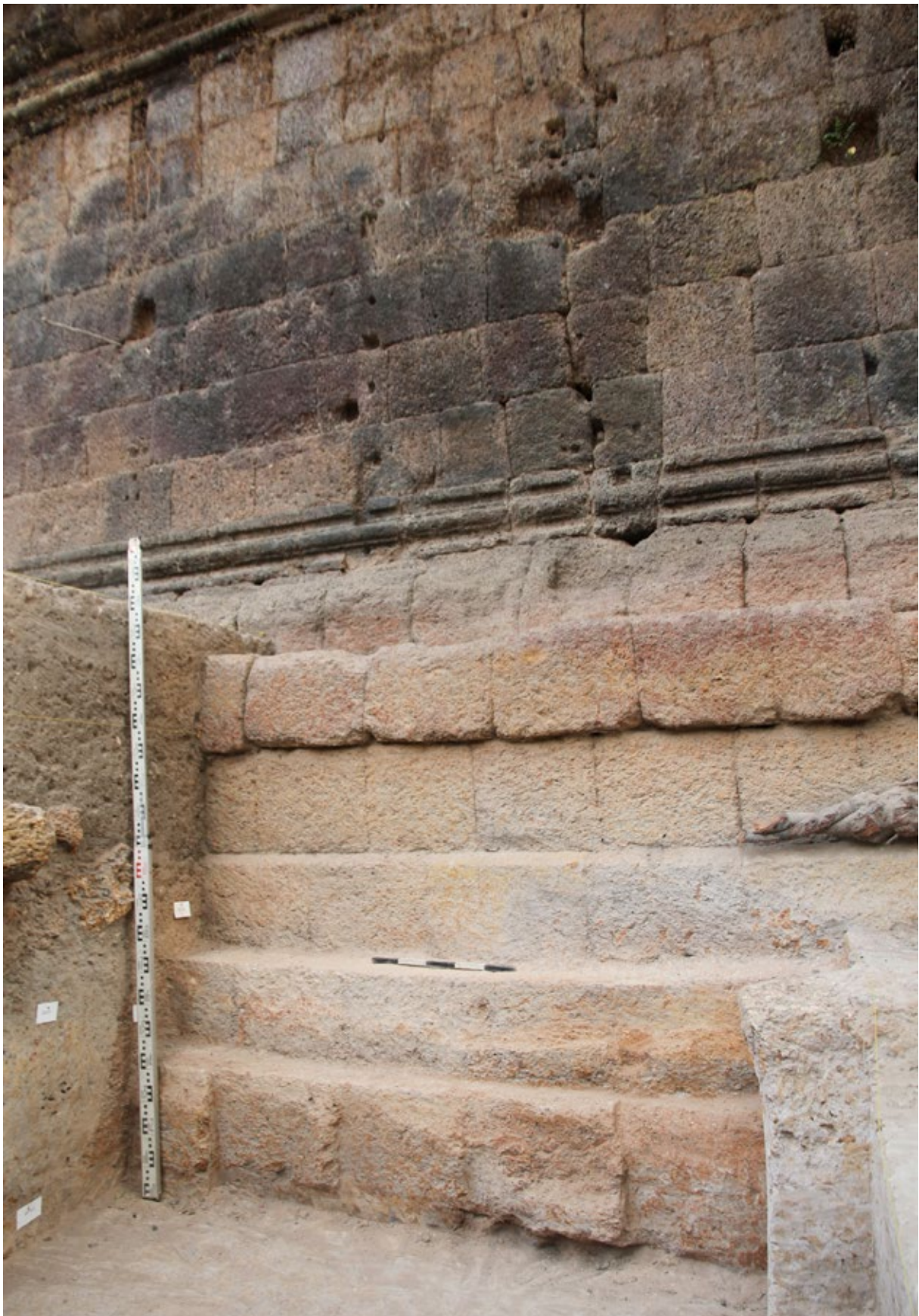
Mise au jour du socle du mur d'enceinte du Palais royal d'Angkor.
