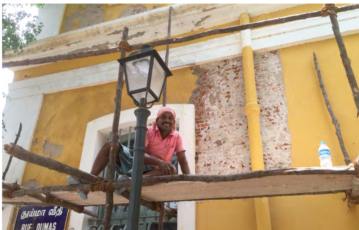
Restauration de la face de la rue Dumas (Centre EFEO de Pondichéry).
