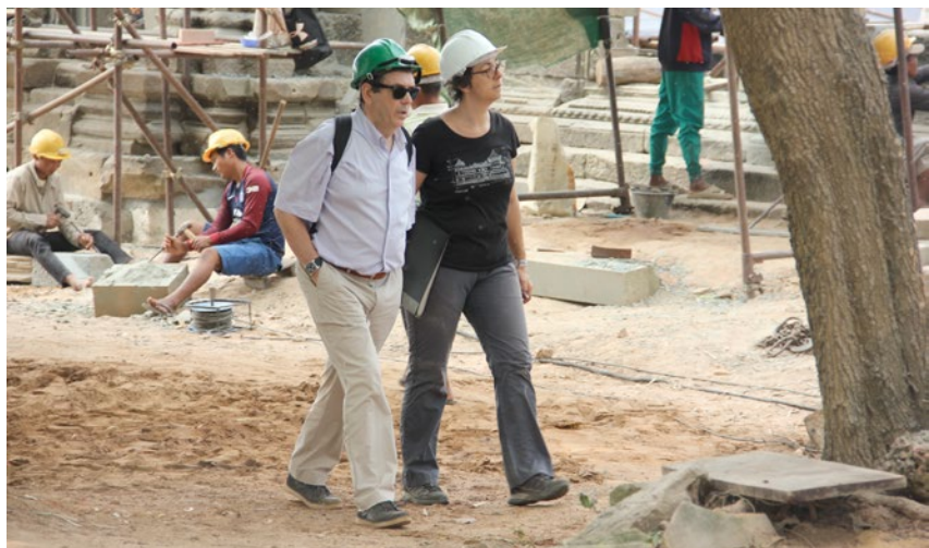
Pierre-André Lablaude, Inspecteur Général des Monuments Historiques et expert ad hoc du Comité International de Coordination, et Maric Beaufeïst sur le chantier de restauration du Mébon occidental (décembre 2017).
