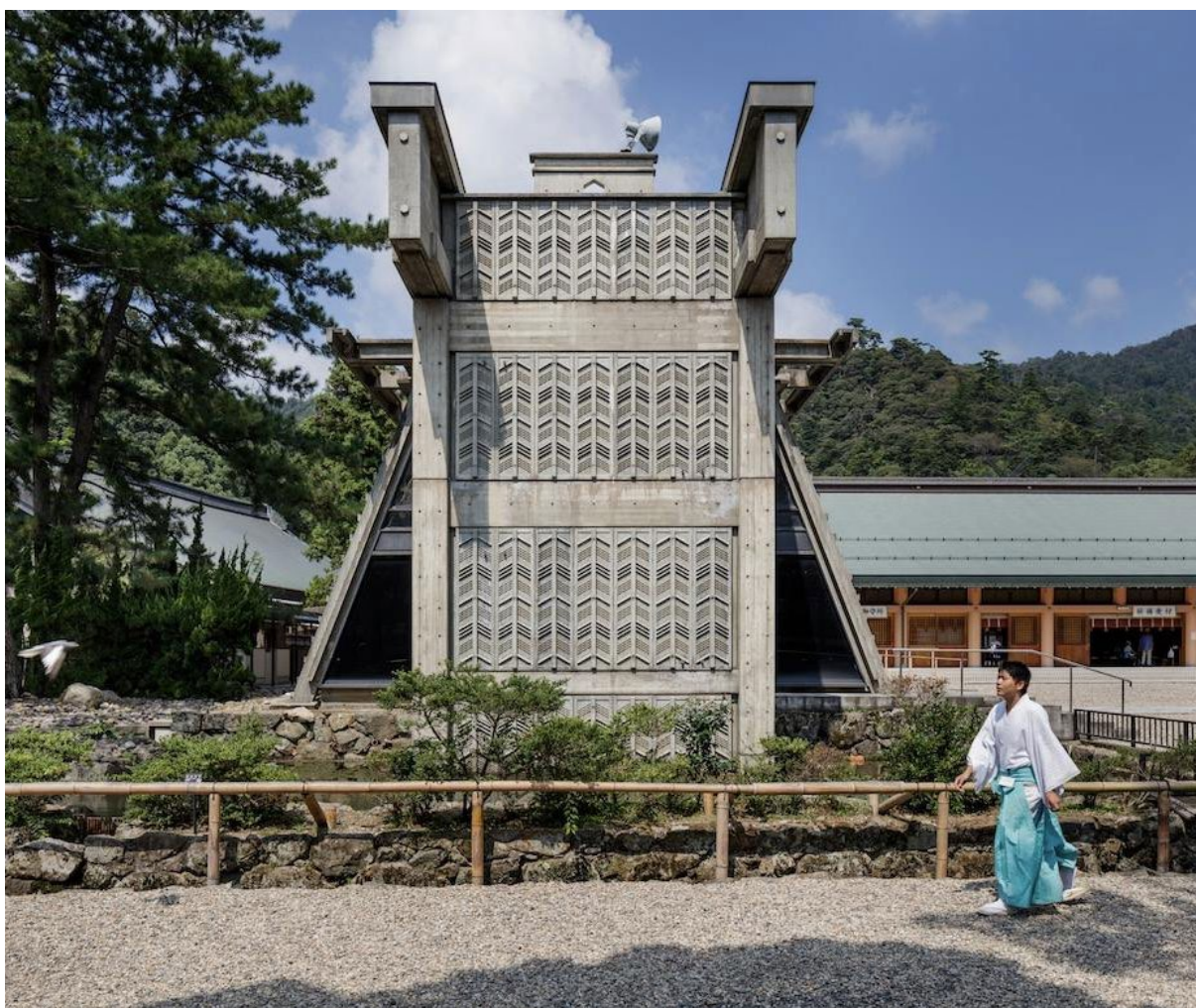
Annexe administrative du Grand sanctuaire d'Izumo, construite en 1963 par Kikutake Kiyonori, détruite en 2016.
