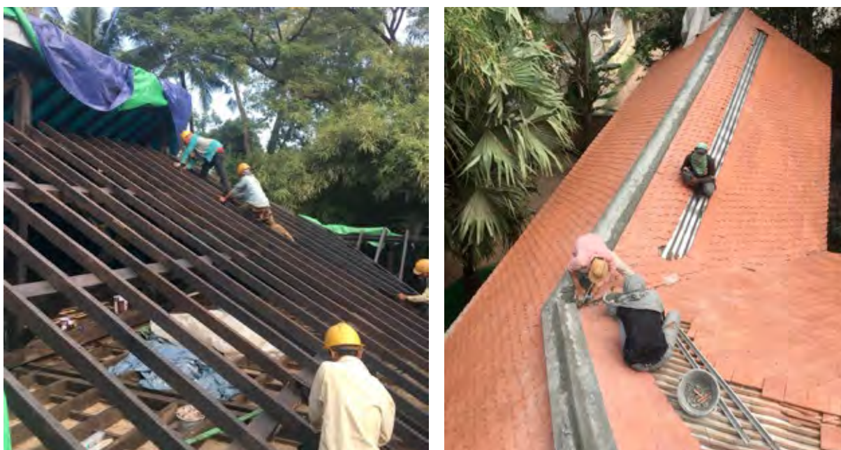
Travaux sur le toit d'un des bâtiments du Centre EFEO de Siem Reap. Photos Éric Bourdonneau.
