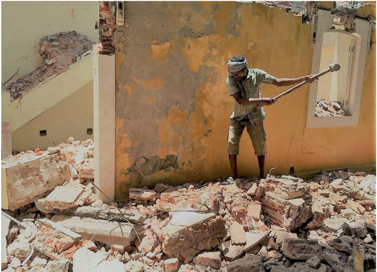
Travaux de construction de l'annexe du Centre EFEO de Pondichéry (cliché D. Goodall, septembre 2016).
