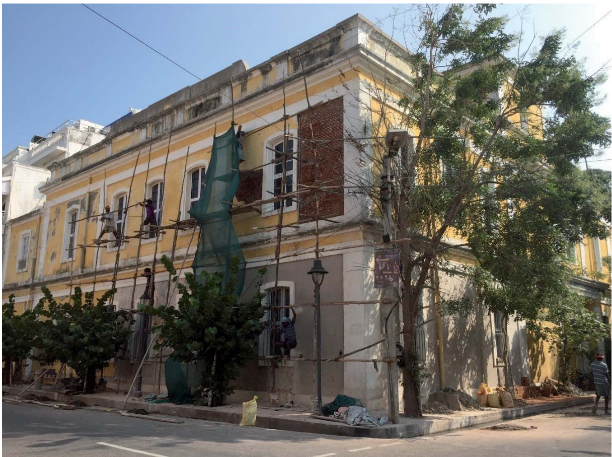
Ravalement du Centre EFEO de Pondichéry (cliché D. Goodall, mars 2017).
