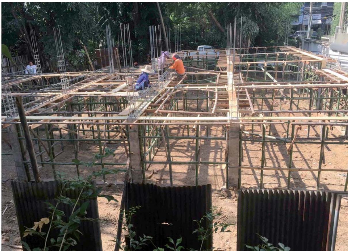
Construction de l'extension du Centre de Chiang Mai (cliché M. Lorillard, novembre 2016).
