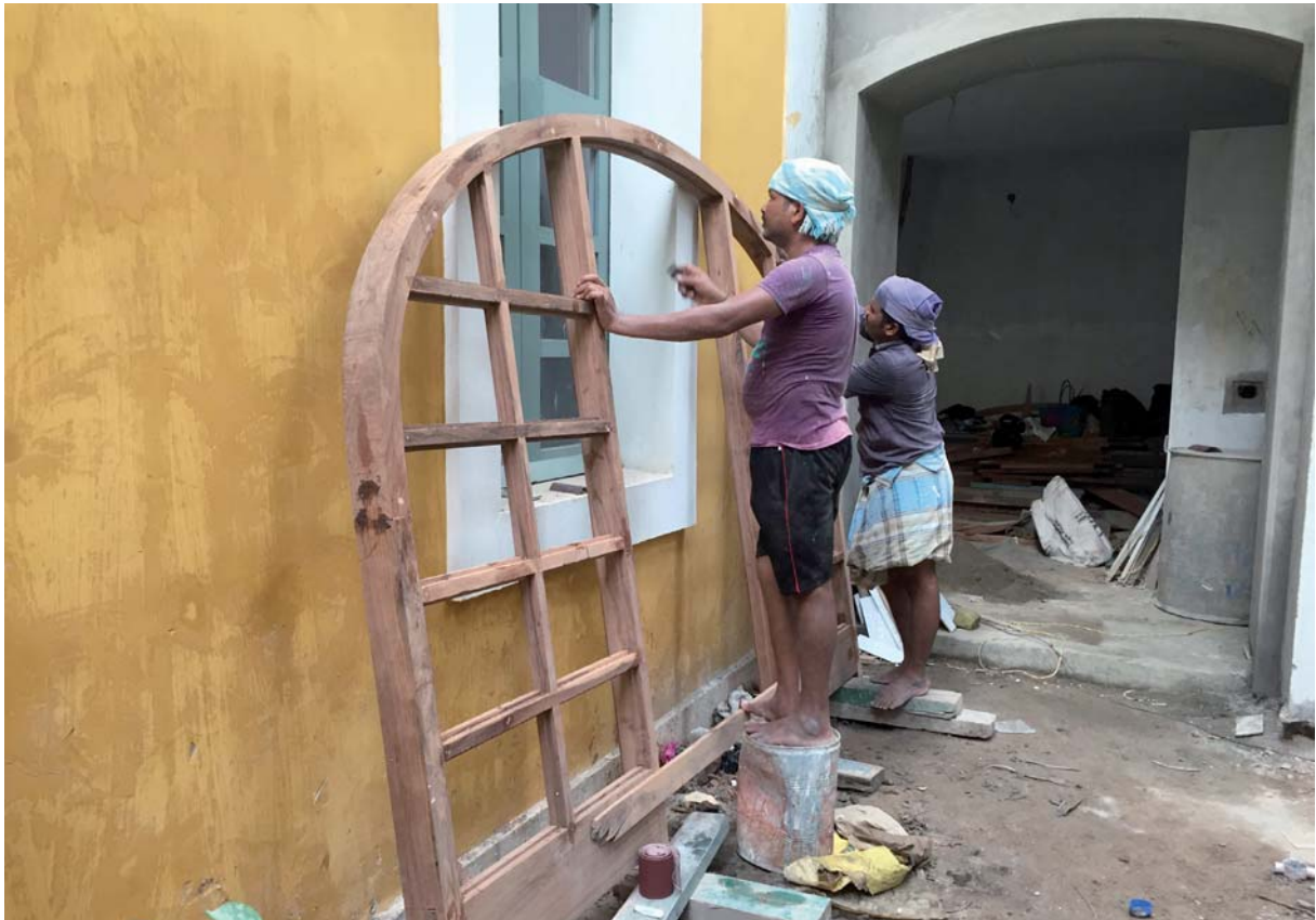
Construction de l'annexe du Centre EFEO de Pondichéry (cliché D. Goodall, février 2017).
