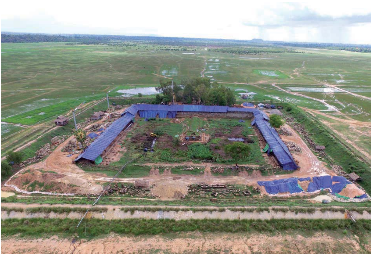
Chantier de restauration du Mebon occidental (Cambodge) dirigé par Marie-Catherine Beaufeist, 2016 (clichés Marie-Catherine Beaufeist)
