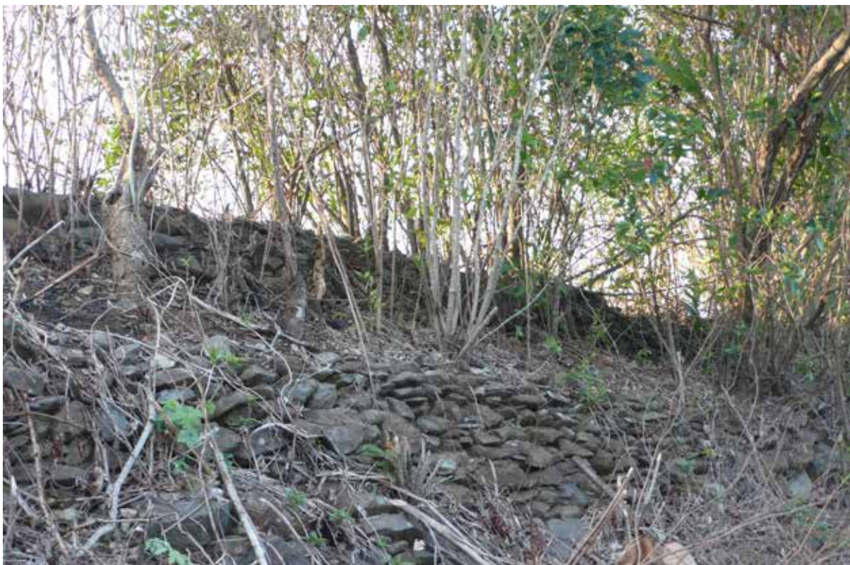
Deux vues d'une section méridionale de la muraille, construite en 1876. Commune de Hoài So'n, district de Hoài Nho'n, province de Binh Dinh. (cliché Andrew Hardy, 2015).
