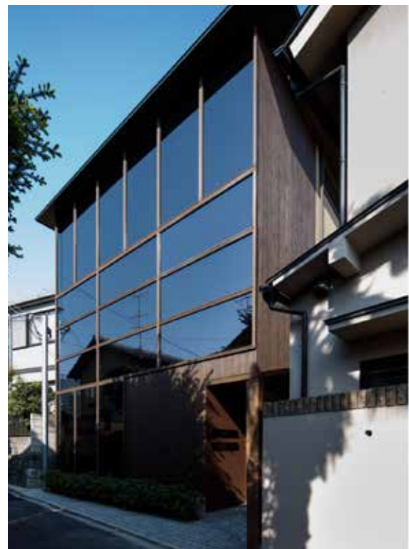
Façade du nouveau Centre de l'EFEU à Kyôto, le vitrage électrochrome s'obscurcit automatiquement en fonction de l'intensité lumineuse, 24 avril 2014 (cliché de Jérémie Souteyrat)
