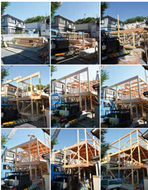
Montage de la charpente en bois, en deux journées, les 19 et 20 septembre 2013 (clichés de Benoît Jacquet)
