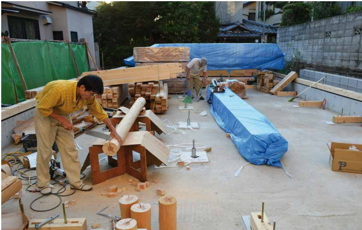
Découpe manuelle des poteaux en cryptomère de Kitayama (Kitayama sugi), derniers préparatifs avant le montage de la charpente, le 18 septembre 2013 (cliché de Benoît Jacquet)
