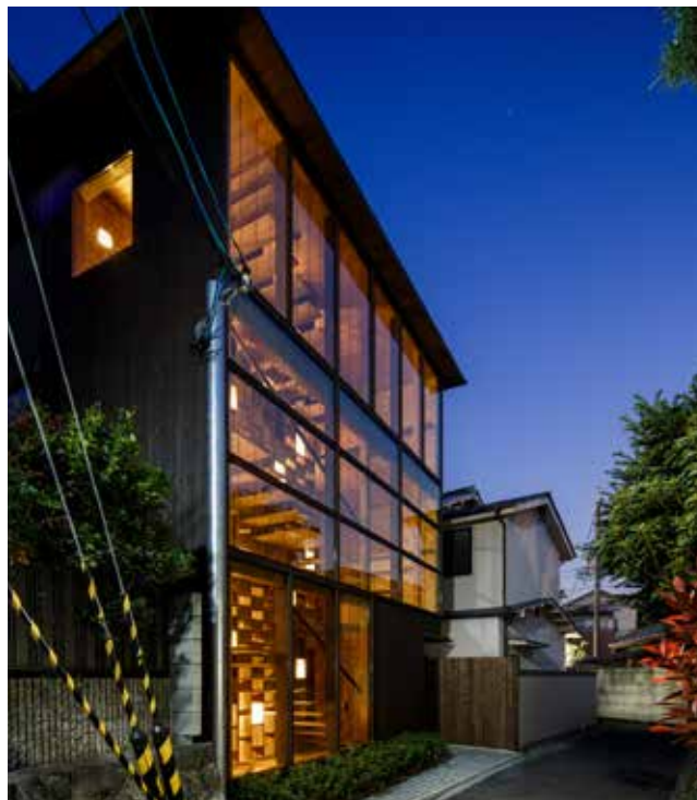
Vue de la façade principale du nouveau Centre de l'EFEO à Kyôto la nuit, 24 avril 2014 (cliché de Jérémie Souteyrat)
