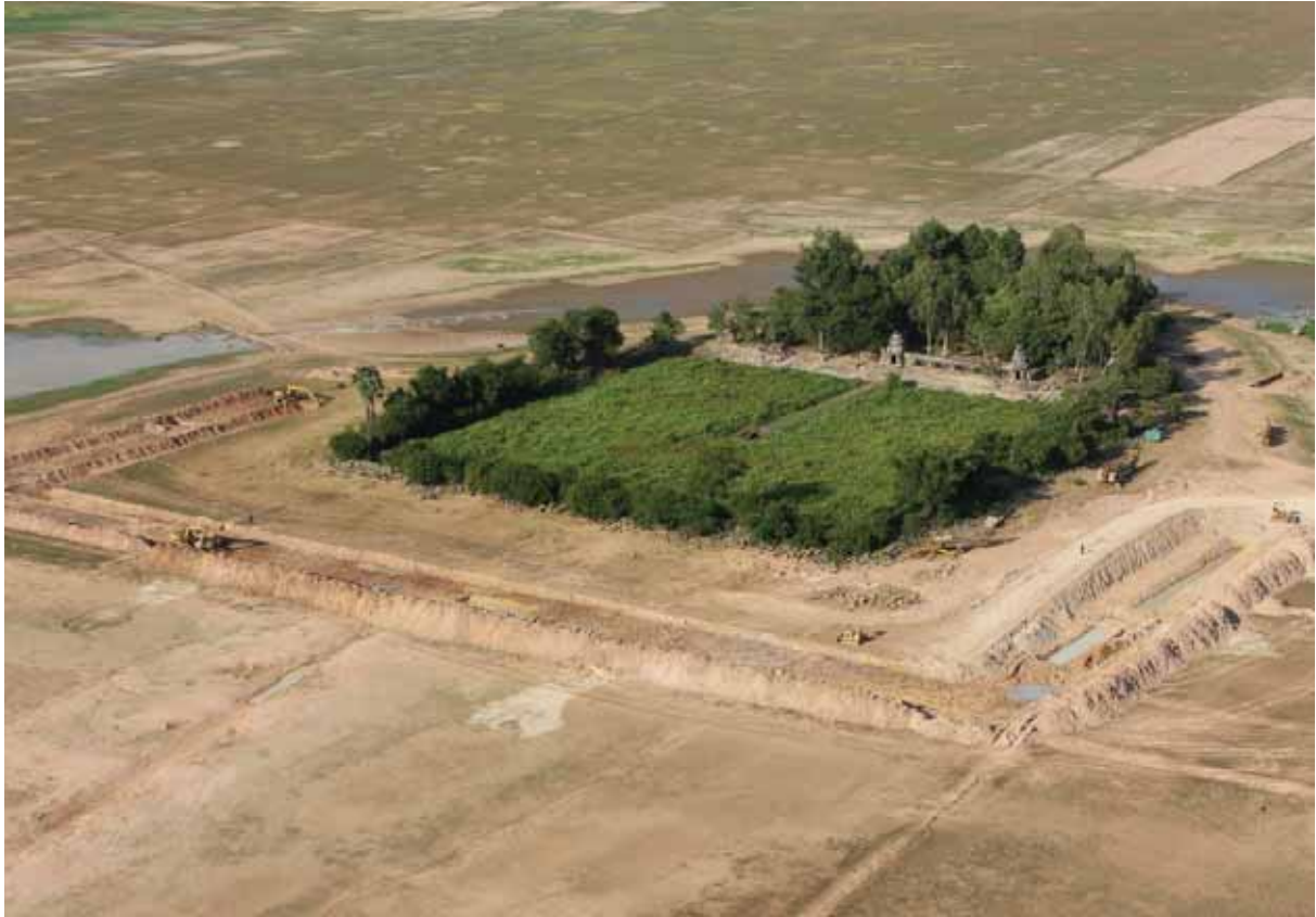
Vue aérienne du chantier de restauration du Mébon oriental (Angkor, Cambodge), 26 avril 2012 (photographie Pascal Royère)
