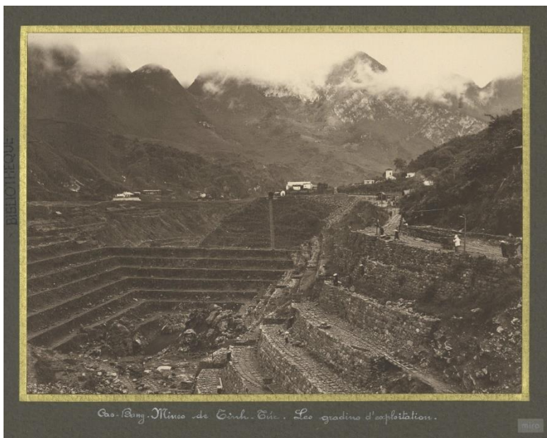
Photographie 5 : Gradins d'exploitation de la mine de Tinh Tuc, commande du Gouvernement Général de l'Indochine, 1921-1931. Université Côte d'Azur. BU Lettres Arts Sciences Humaines. Fonds ASEMI, PH08-13
