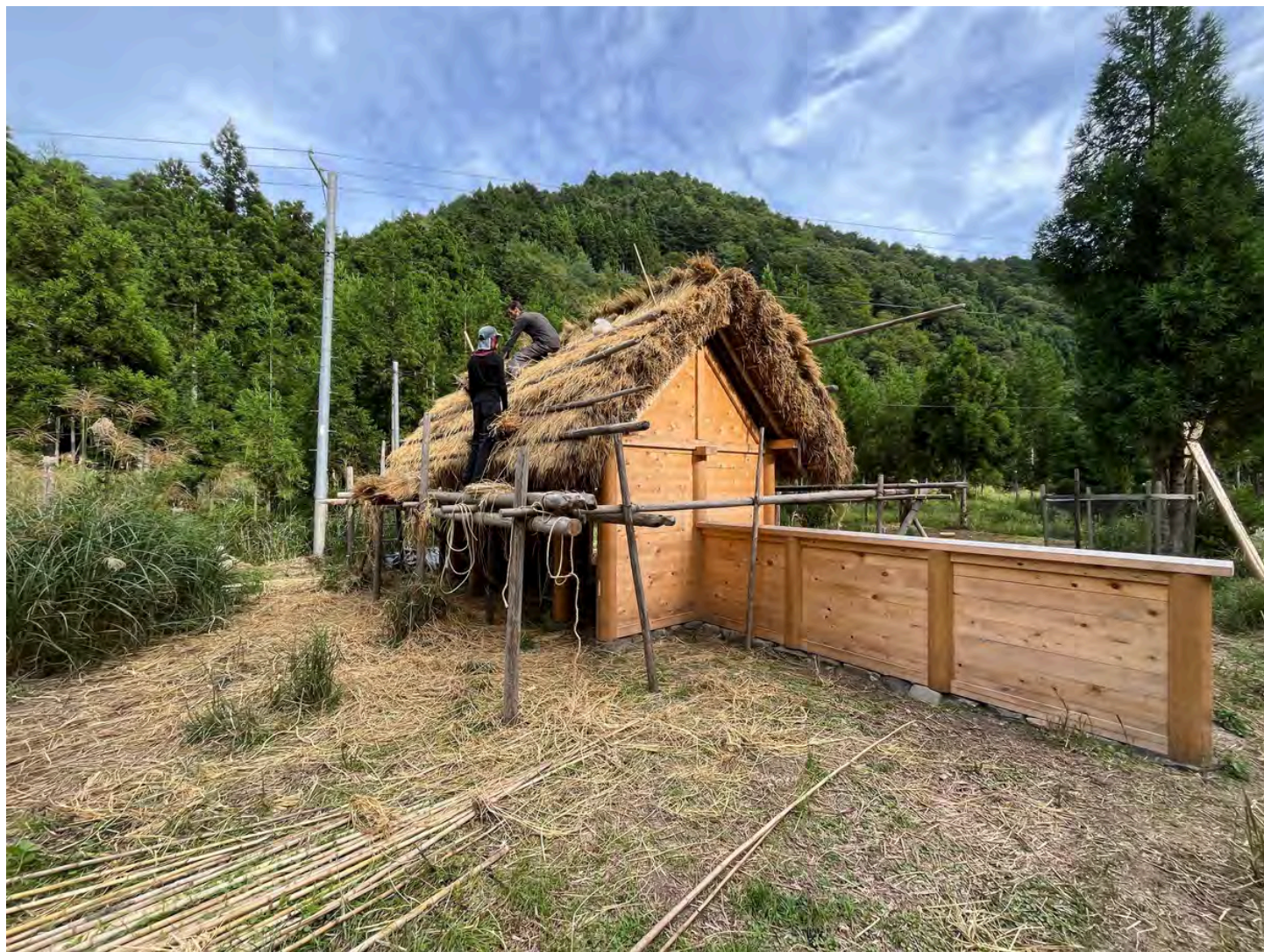
Construction d'une porte ( mon ) en bois de cyprès ( hinoki ) avec couverture en paille de riz ( ina-buki ), Atelier 2m26, Keihoku, Ukyô-ku, Kyôto, 20 septembre 2024 ©Benoît Jacquet.
