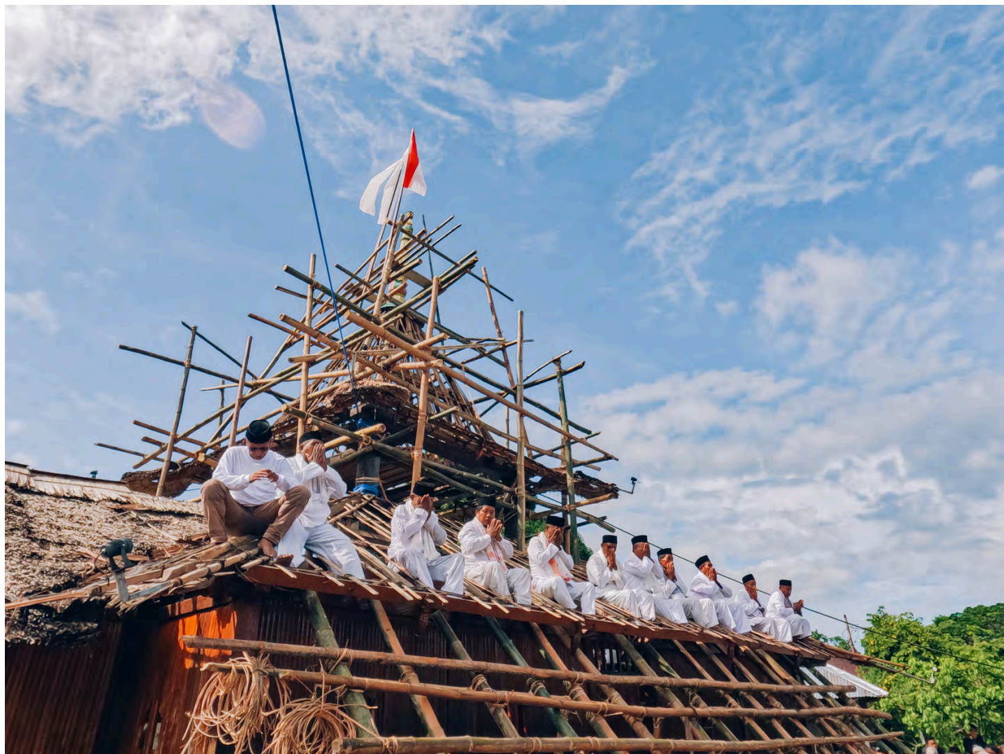
Prières musulmanes et hommage aux ancêtres par les 10 maîtres charpentiers de Kaitetu avant la mise en place du toit apotropaïque de la mosquée Wapauwe. Ambon, 08/01/2025 (©Ikrima Hatuwe)
