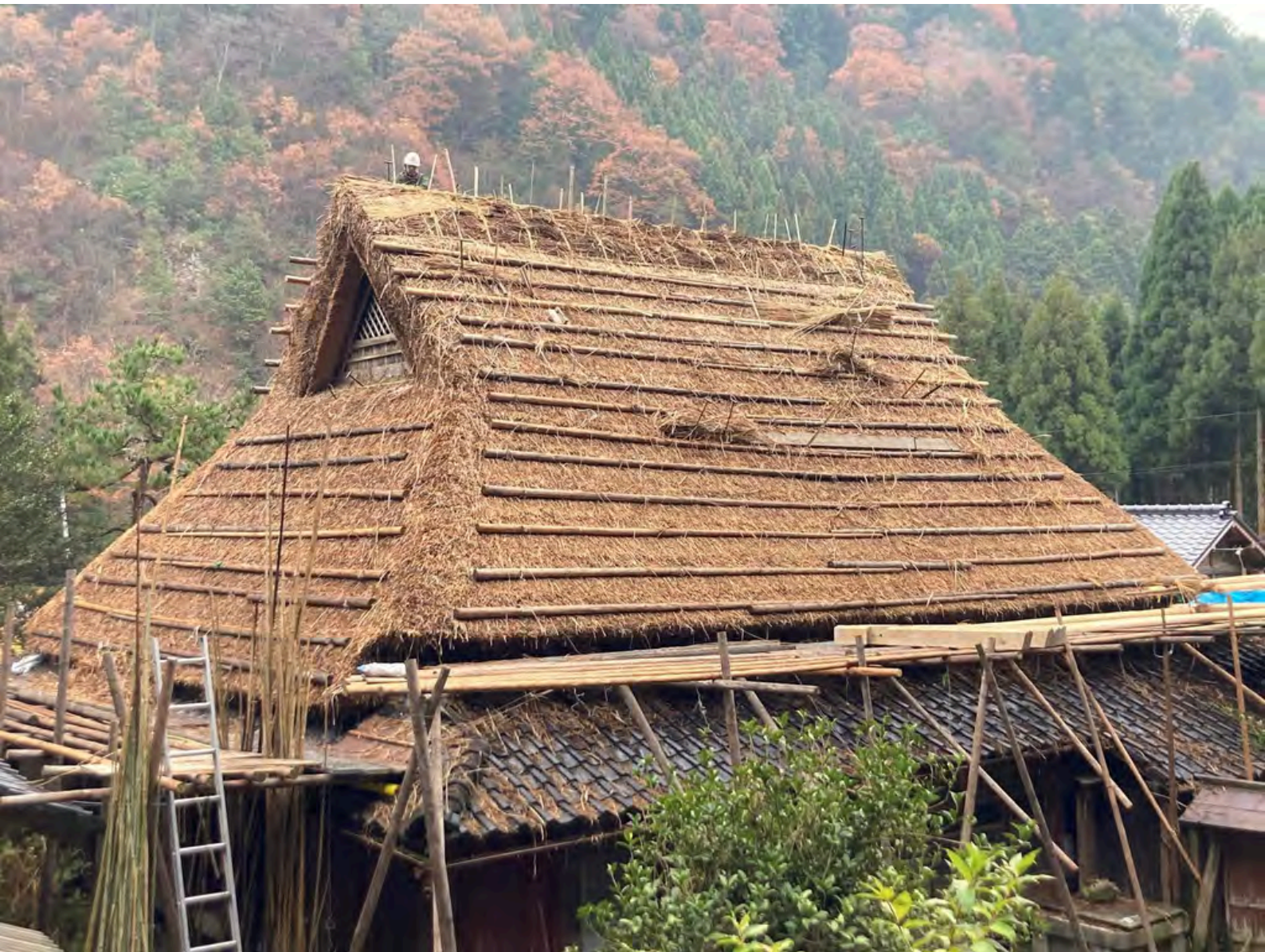
Restauration de la toiture d'une maison à toit de chaume ( kaya-buki minka ) dans la commune de Keihoku (Kyoto, Ukyō-ku), phase de remplacement et de remplissage de la couverture de chaume ( kaya ). Novembre-décembre 2023 (cliché : atelier 2m26)
