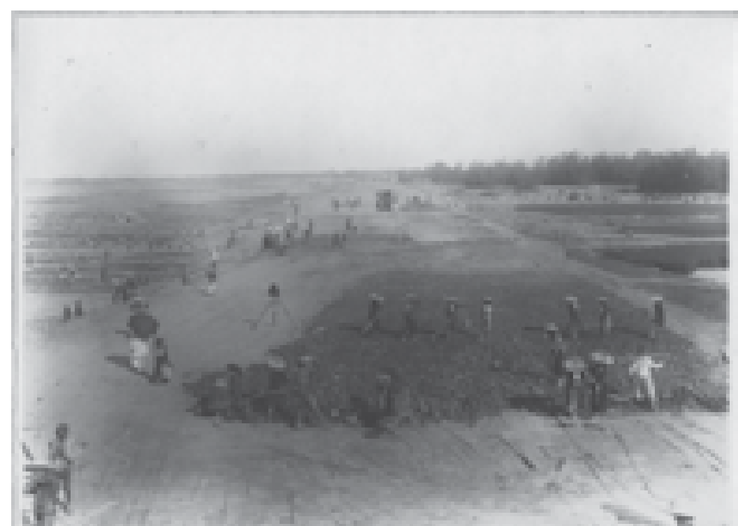
Renforcement et élévation de la digue de Gia Lâm (1926) / Đắp đê Gia Lâm (1926)
