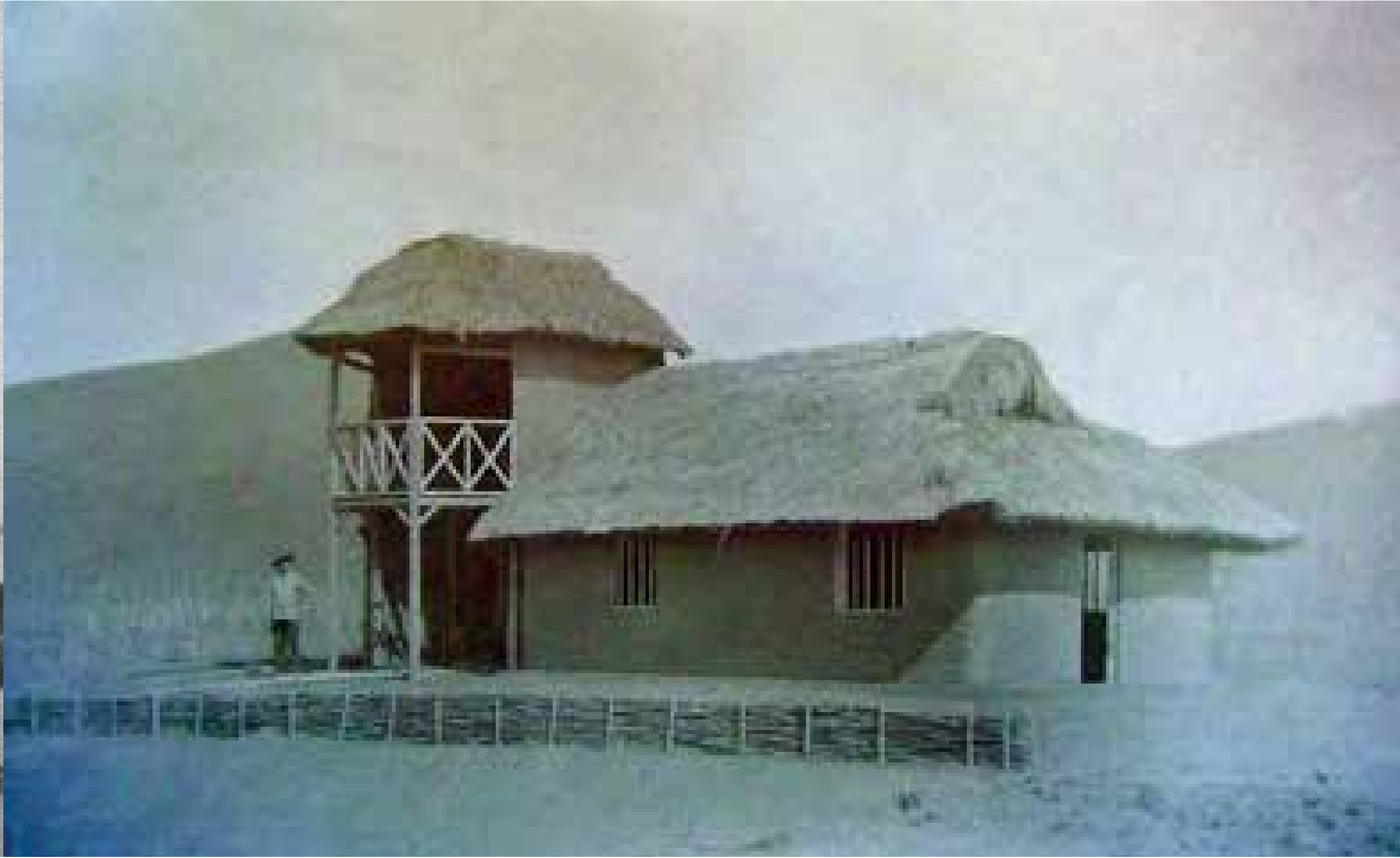
1 re maison en torchis construite par les moines de la mission de Đăng Kia, Jacquet 1898 [ANOM GGI 5956_17] Ngôi nhà vách đất đầu tiên được các thầy tu của Hội truyền giáo Đăng Kia xây cất 1 st mud brick house built by the monks of the Đăng Kia mission
